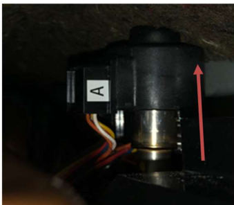
Cewka założona nieprawidłowo, wysunięta z głowicy:
